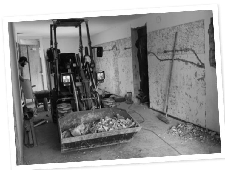
Schwere Maschinen im Eingangsbereich
