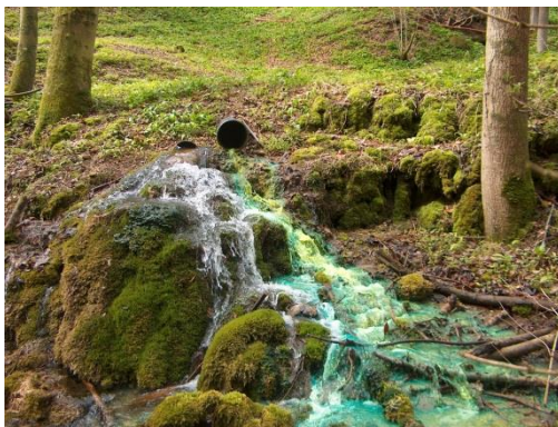
Abb. 4.2: Auslauf Meteorwasserleitung
