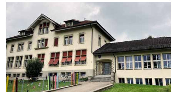
Abb. oben: Kindergarten Zuckenriet Abb. unten: Altes Schulhaus Niederhelfenschwil
